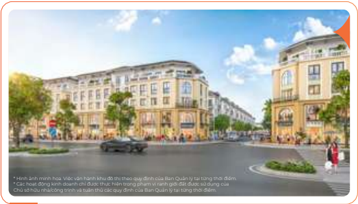
Kiến trúc shophouse Vinhomes
